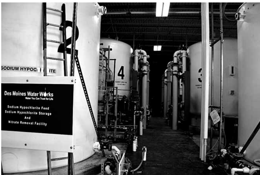
Die Nitratfilteranlage
