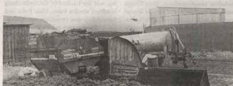
Eine Biogasanlage muss mit organischen Substanz befüllt werden, um Gas zu erzeugen, das in Motoren verbrannt wird, um so Strom zu erzeugen. Mit Hilfe des Mischwagens (links im Bild) werden hier Trester und Mist in den Grubenschacht (Bildmitte) gefüllt und so der flüssigen Gülle zugeführt. Foto: Jasper
