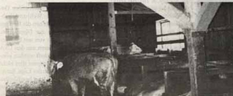
Sackgassen wie diese sollten vermieden werden, um gefährliche Panikreaktionen auszuschließen.
