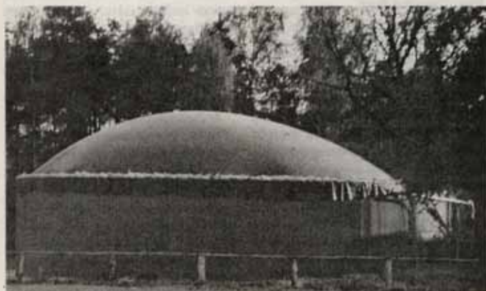
In diesem Gärbehälter (Fermenter) wird organische Substanz von Bakterien zersetzt. Dabei entsteht das gewünschte Biogas.
